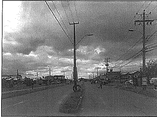
Figura 2: Luminaria existente en el arco Norte de la intersección Anortosita- Granítica.
