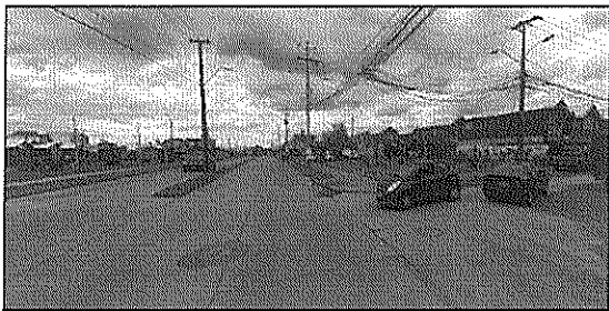
Figura 4: Luminaria existente en el arco Noreste de la Intersección Anortosita- Granítica.
